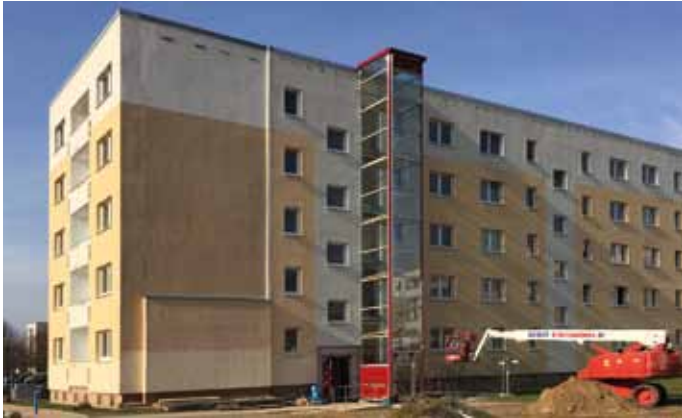
Die Sanierung in der Bürgelstraße läuft auf Hochtouren.
