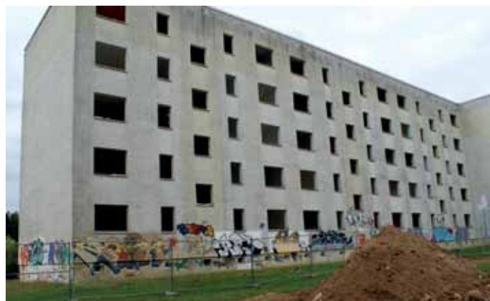
Mitte Juli hat der Abriss von 250 Wohnungen begonnen, die von der Landeshauptstadt Anfang des Jahres vom Bavaria-Verwalter ARWOBAU erworben wurden. Vor dem Abriss konnten Jugendliche in der Hamburger Allee 226-238 die Wände offiziell besprühen.
