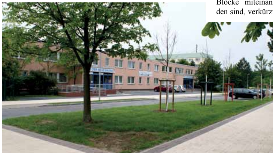
Die Baumaßnahmen im Bereich Perleberger, Stralsunder und Potsdamer Straße sind abgeschlossen. Im Herbst müssen noch die nicht angewachsenen Zierkirschen im Rahmen der Garantie ersetzt werden.
