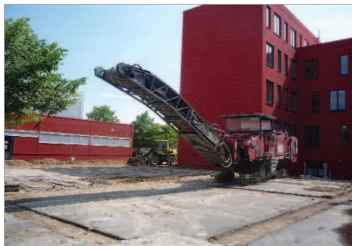
Der Asphalt muss zunächst aufgefräst werden.
