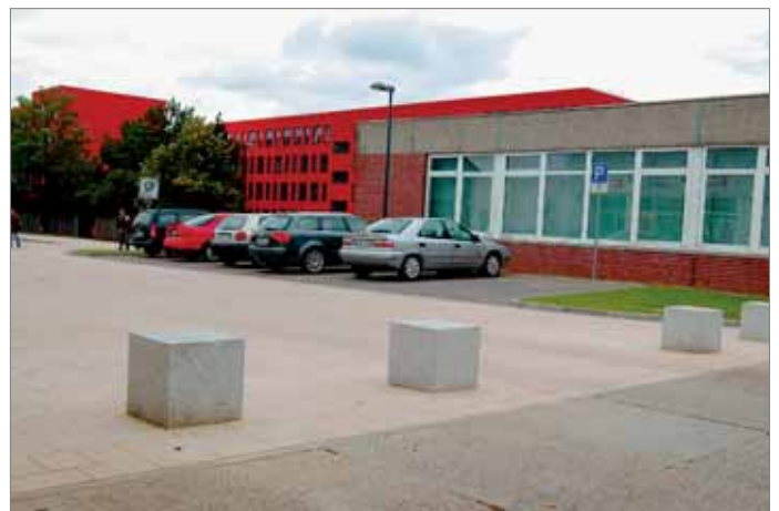
Im Rahmen des Stadtumbaus werden auch Straßen, Wege und Parkplätze neu gestaltet. Hier ein Blick auf den neuen Bereich an der Post.
